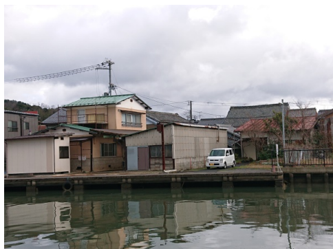
■ 西側の河川敷から土地・建物を見る
