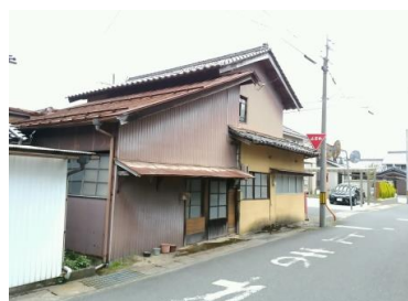
解体前の建物が建ってありました(現在は、更地です)。
