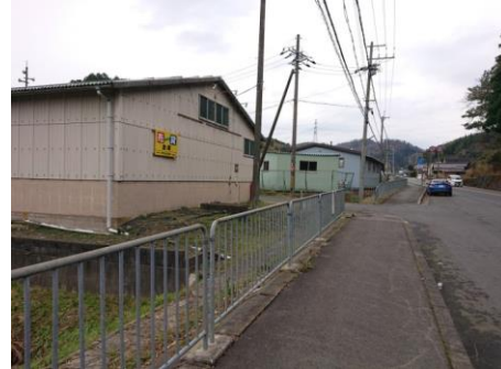
国道27線を東舞鶴方面より建物を見る
