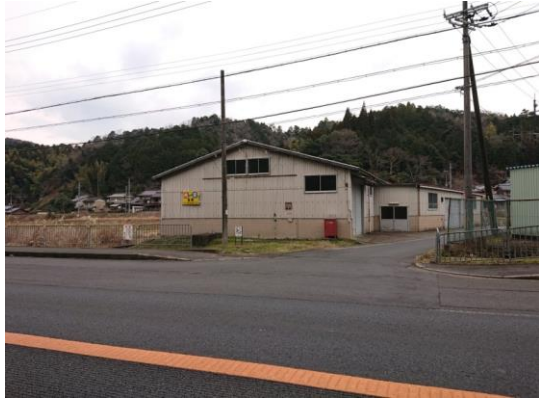
国道27号線の南側より建物を見る
