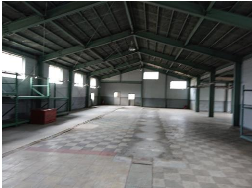
建物内を国道側の出入り口より奥を見る
